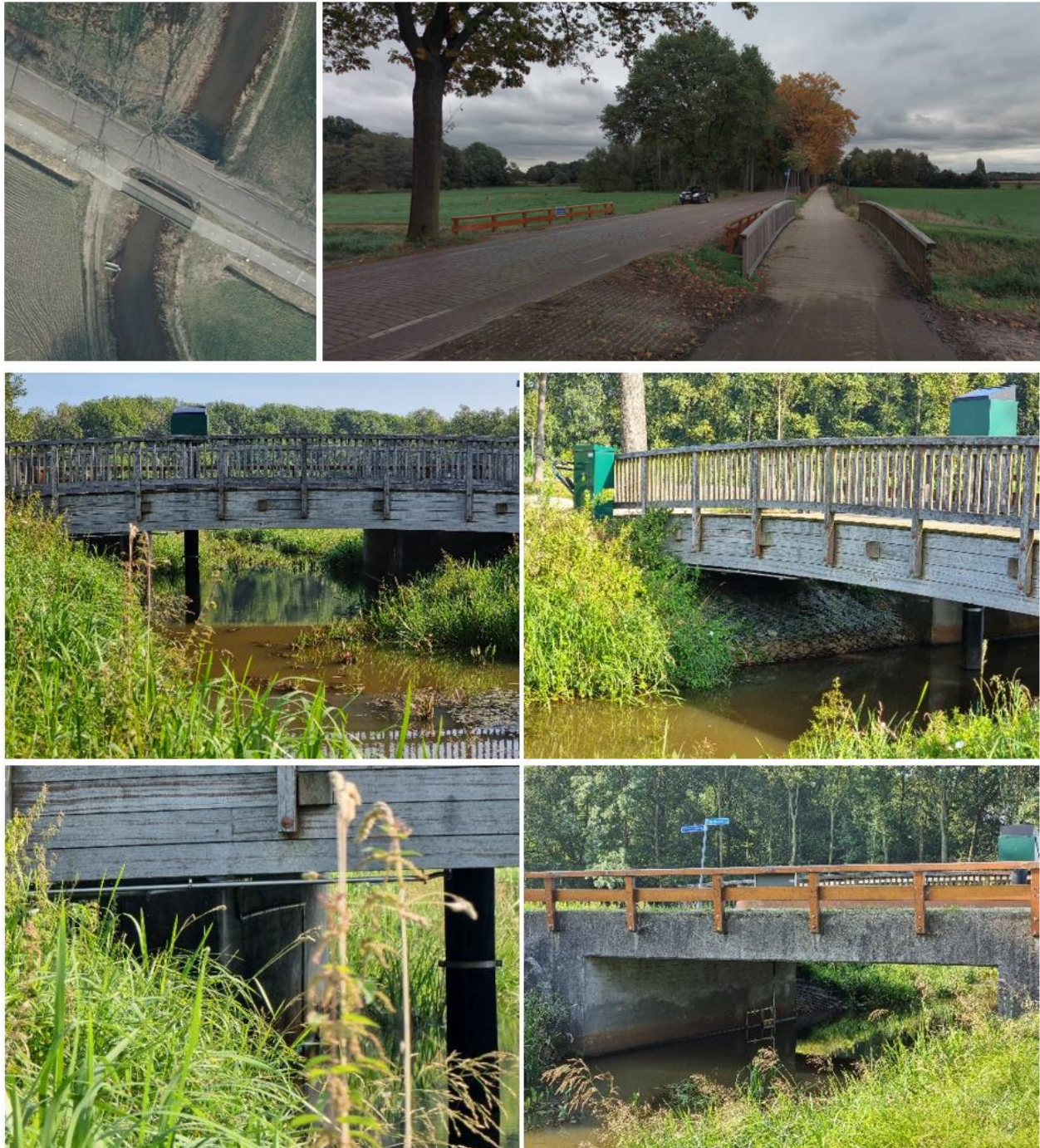
Figuur 1.5-20 Huidige situatie brug De Hoeve
